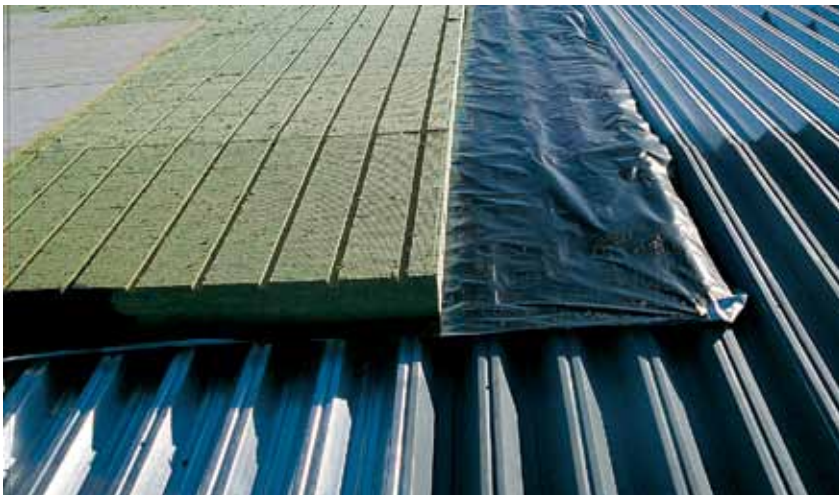
Система PAROC Air в процессе монтажа
