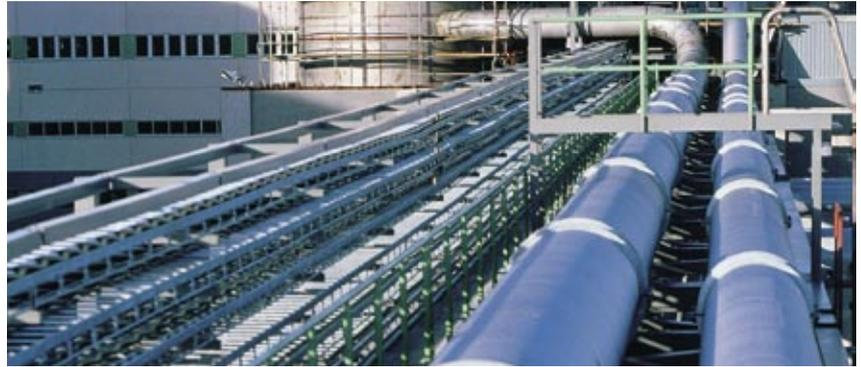
Изоляция трубопровода с высокими температурами одним слоем цилиндров.
