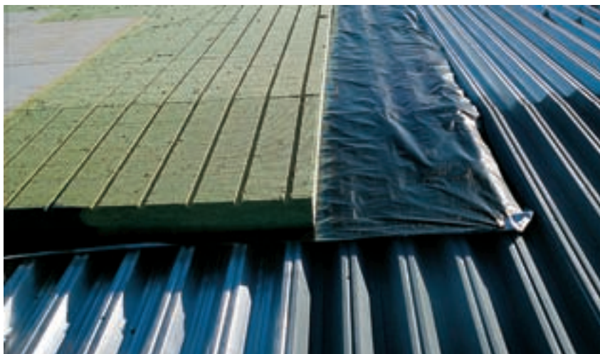
Система PAROC Air в процессе монтажа
