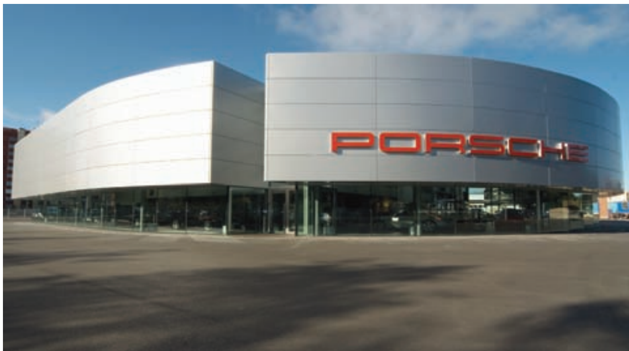
Автосалон «Порше», Санкт-Петербург, материал PAROC ROS 30 + PAROC ROB 80†
